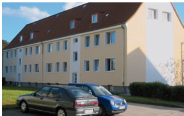
SEIT JULI 2004 VERSORGEN ZWEI HEIZÖLBETRIEBENE MINI-BHKWS SECHS WOHNBLOCKS MIT STROM UND WÄRME
